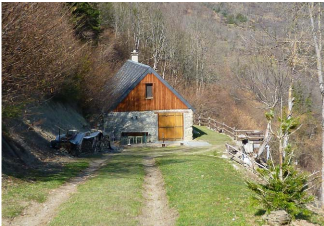
Une grange résidentialisée tout près du village d'Ancizan, en contrebas de la route d'accès à la Hourquette.
