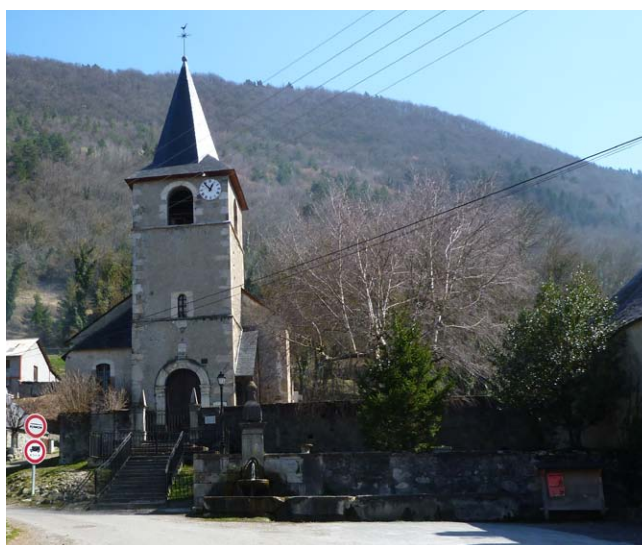
Vue d'ensemble de l'église et la fontaine-abreuvoir
