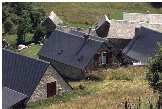
Adaptation du bâti dans la pente.
