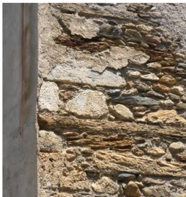
▲ Appareillage mixte de pierraille calcaire et de lauzes de schiste, permettant un blocage efficace de la maçonnerie par l'alternance des lits. L'angle est renforcé par des blocs de calcaire ébauchés.
