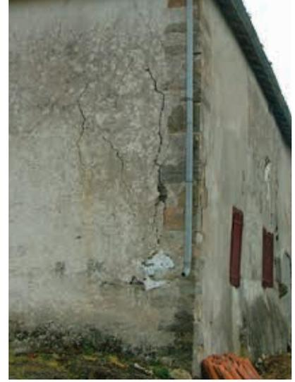
▲ Exemple de fissuration et désolidarisation de la chaîne d'angle, fréquent sur le bâti ancien en pierre.
