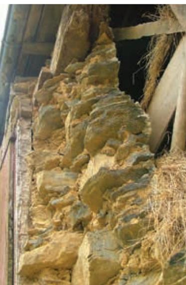
▲ Mur de grange à double parement de schiste, lié au mortier de terre argileuse.
