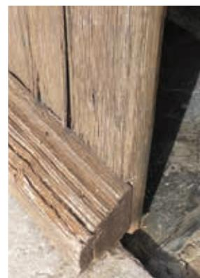
▲ Détail de plinthe rejet d'eau sur une porte en chêne.
