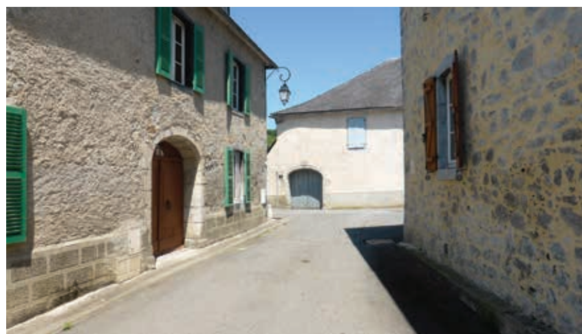
⬆ Mise à nu de la pierre et rejointoiement avec un enduit de teinte jaune soutenue, contrastant avec le gris de la pierre maçonnée, mais aussi avec les teintes terre ou pastel du village. © C.A.U.E.64
