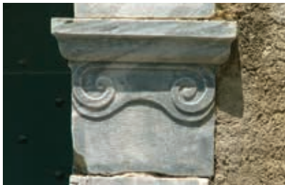
▲ Enduit rustique venant à fleur des clavaux en pierre de taille d'un encadrement en marbre. © C.A.U.E.64
