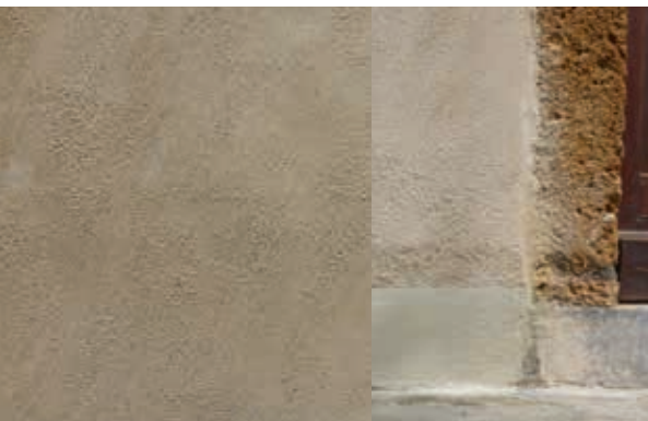
⬆ Effet de texture gratté faisant apparaître le grain de manière trop uniforme et rendant visible de longues lignes obliques, à éviter. © C.A.U.E.64
