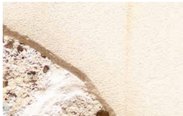
⬆ Finition « grattée fin » d'un enduit projeté, uniformité à l'image du neuf. © C.A.U.E.64
