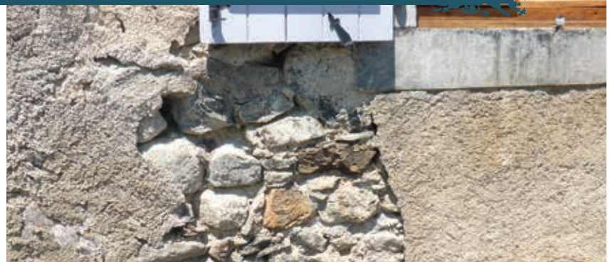
▲ Détail d'enduit rustique jeté recoupé en une seule couche. © C.A.U.E.64
