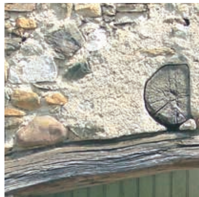
▲ Enduit rustique. © C.A.U.E.64
