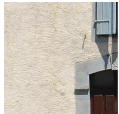
▲ Enduit jeté-recoupé à la truelle. © C.A.U.E.64
