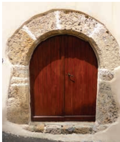
⬆ Surrèpasseur d'enduit « avalant » l'encadrement en calcaire local. © C.A.U.E.64
