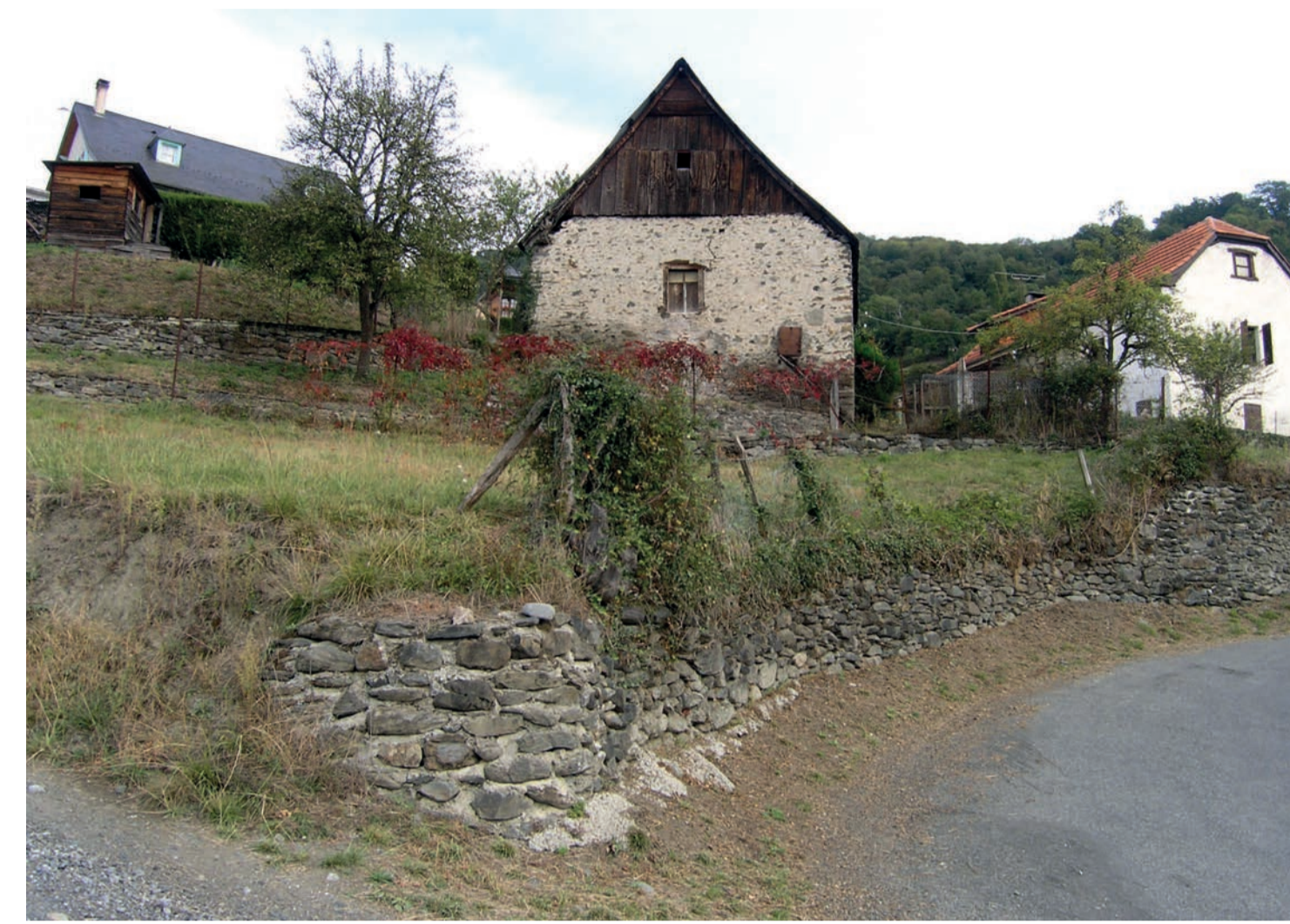
Beaucens (65) - mur de soutènement chemin de Nouilhan
