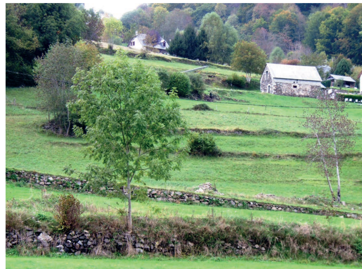
Soutènement entre la Vialette et Lesponne (65)
