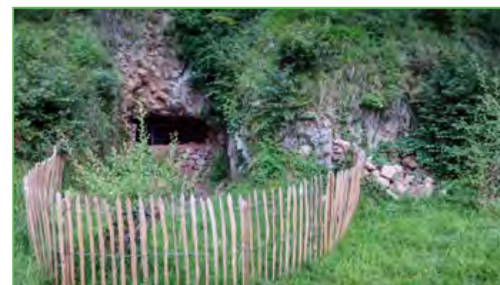
▲ Mines de Bahuret- aménagement des entrées de galeries
