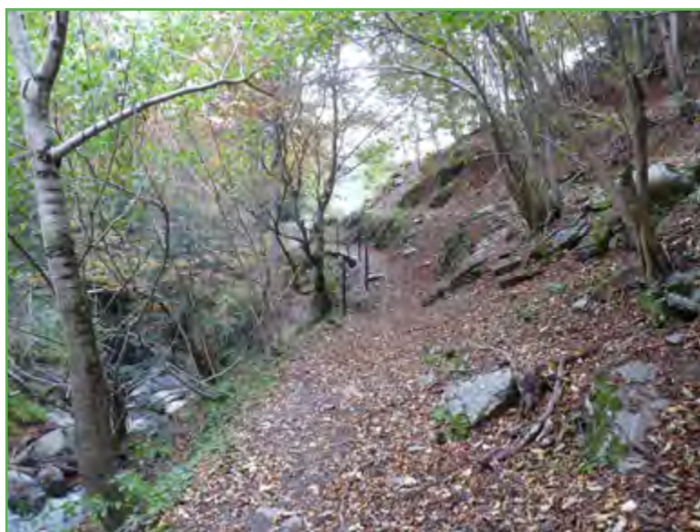
▲ Autorisation de travaux - nouvelle emprise sentier du Barrada / secteur de Luz-Saint-Sauveur
