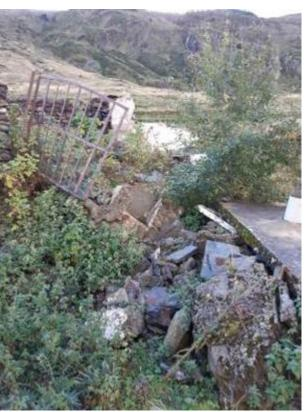
La démolition de l'ancienne cabane et son évacuation par héliportage représentent 11 mètres cubes pour la dalle et de 13 mètres cubes pour les massifs béton et murs.
