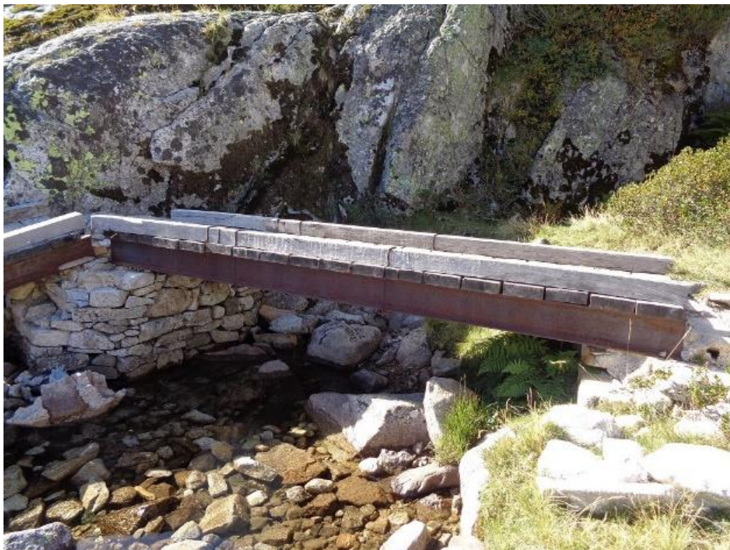
7.2 - Passerelle haute Plaa du Larribet (repère n°2)
