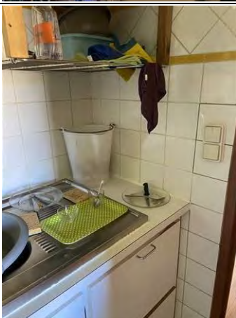
Photo n° PhA022 Localisation : 1er étage - Cuisine/Coin couchage Ouvrage : 3 - Parois verticales intérieures - Revêtements de murs, poteaux, cloisons, gaines, coffres Partie d'ouvrage : Colle de faïence Description : Colle de faïence Localisation sur croquis : M025
