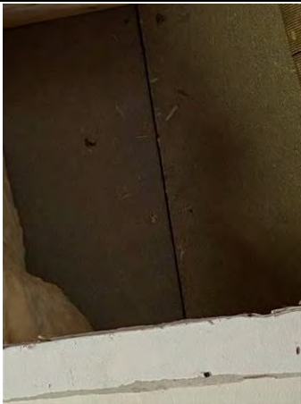
Photo n° PhA020 Localisation : 2ème étage - Dortoir Ouvrage : 4 - Plafonds et faux plafonds - Plafonds Partie d'ouvrage : Panneaux collés vissés ou cloués Description : Panneaux collés vissés ou cloués Localisation sur croquis : M023
