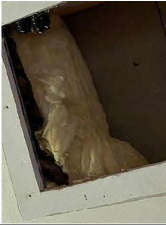
Photo n° PhA019 Localisation : 2ème étage - Dortoir Ouvrage : 4 - Plafonds et faux plafonds - Faux plafonds Partie d'ouvrage : Pare vapeur Description : Pare vapeur Localisation sur croquis : M021
